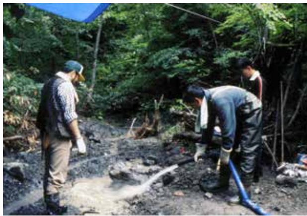
土砂を小型ポンプで流しているところ
